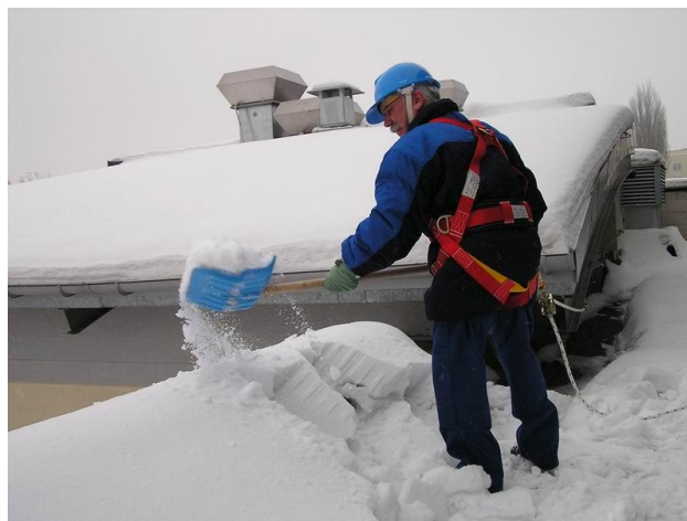
Rys. 9. Przykładowy schemat systemu zapobiegającego spadaniu.
