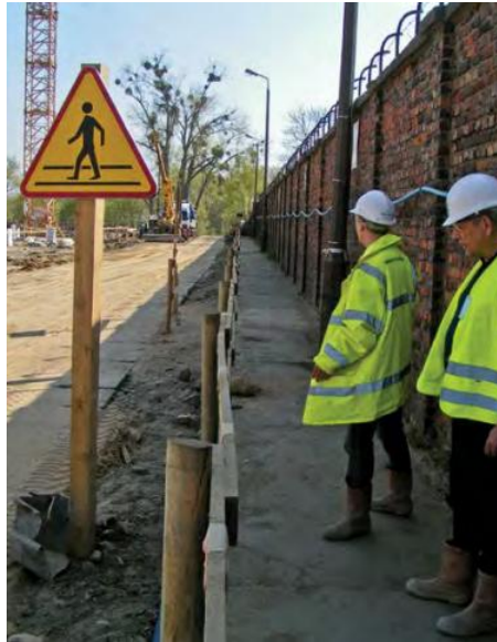
Rys. 5. Oddzielenie dróg dla pieszych od dróg dla ciężkiego sprzętu budowlanego [4].
