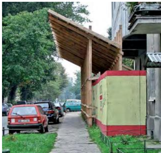
Rys. 6. Daszki ochronne na placu budowy [4].
